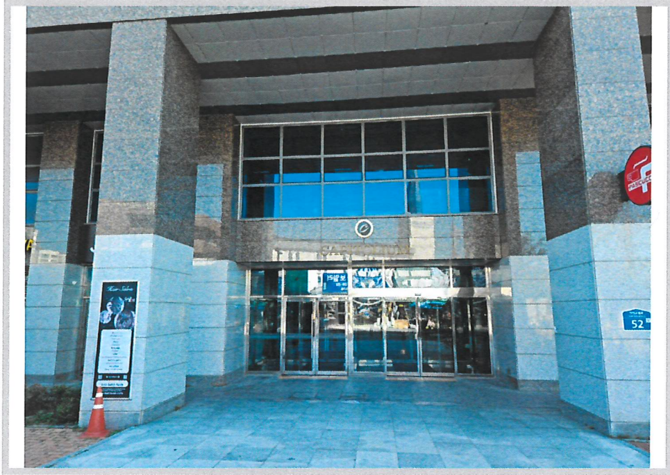
<본건 공동 출입구>
