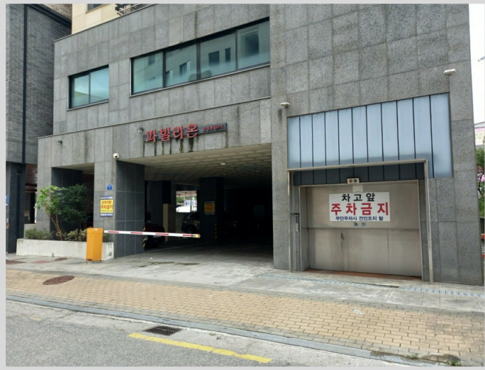
본건동 주차장 출입구 전경
