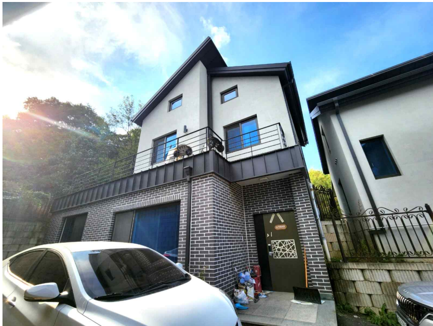
본건 전경(남동측에서 촬영)
