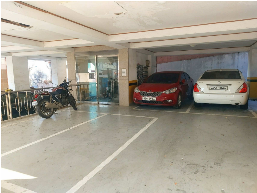
< 1층 주차장 및 출입구 전경 >
