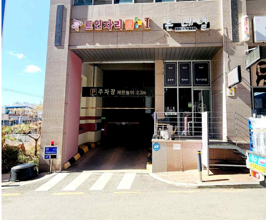
1층 주차장 출입구 전경
