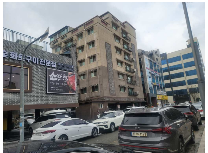
본건 남동측 전경
