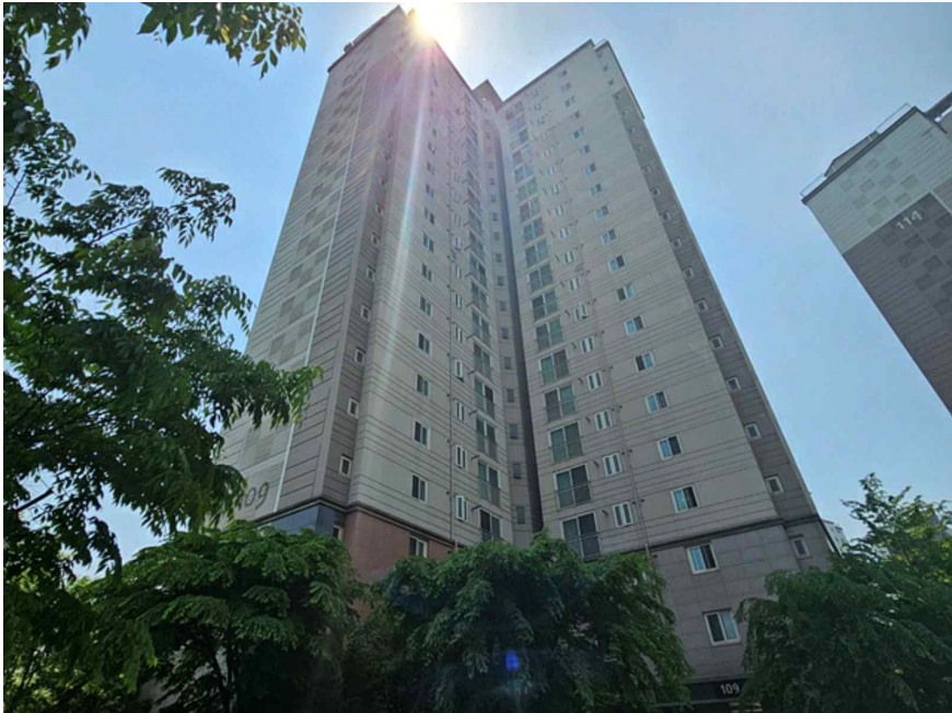
본 건 건물 전 경 - 본건 북서측에서 촬영
