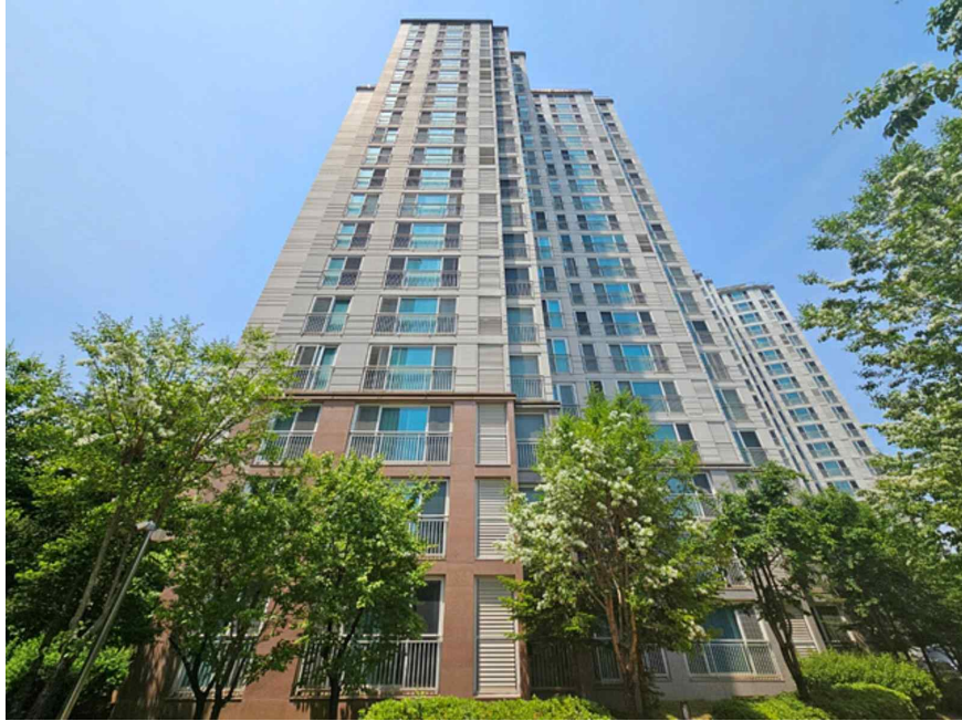
본 건 건물 전 경 - 본건 남동측에서 촬영
