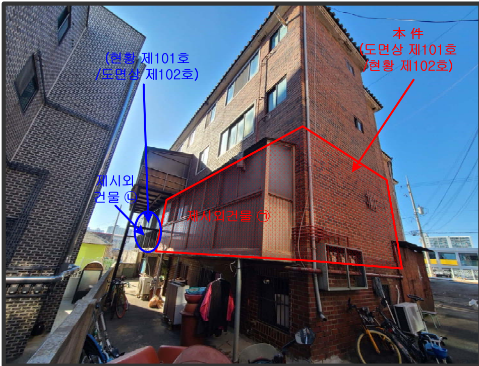
본건 전경 - 본건 남서측에서 촬영
