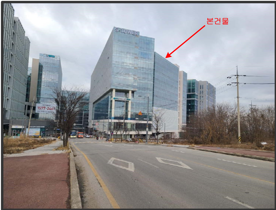
주위환경 - 본 건물 남동측에서 촬영
