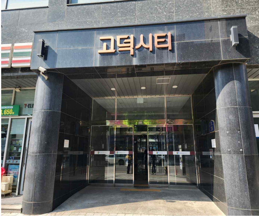
1층 남측 공동출입구 전경
