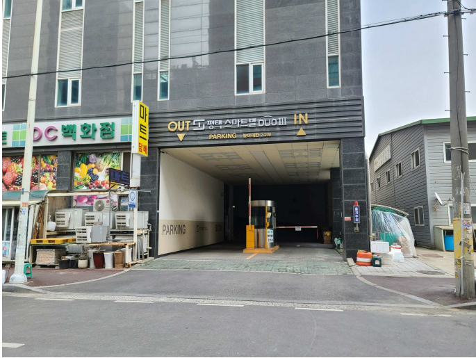
본건물 지하주차장 입구
