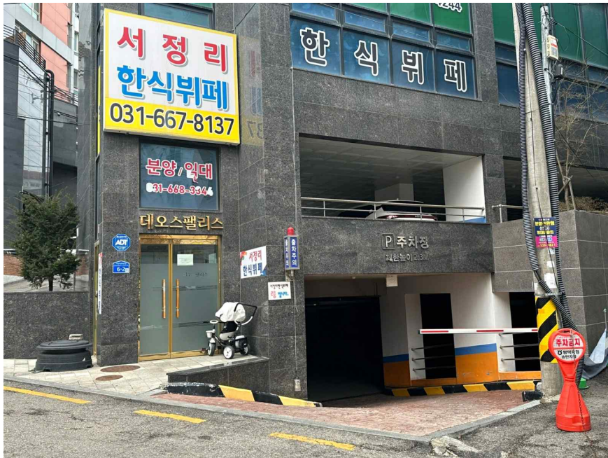
지하 1층 주차장 출입구
