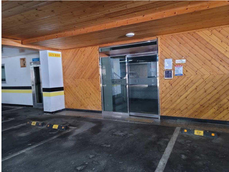
지하1층 출입구 부분
